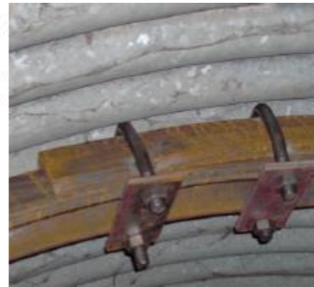
éléments assemblés et mis en place au contact de la buse, constituant une cerce
