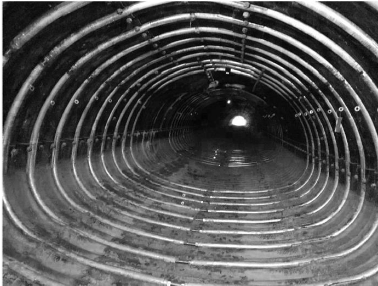
Fig.1 – Photo d'une section de buse renforcée par une série d'anneaux comprimés (3 joints/anneau)
