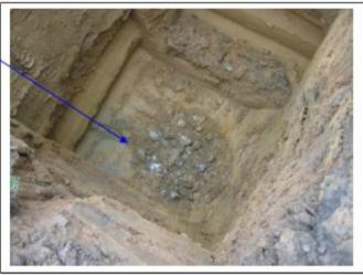
Canalisation en brique de collecte des eaux pluviales de la cour de l'école (exutoire localisé à l'aplomb du puits 76456-202).
