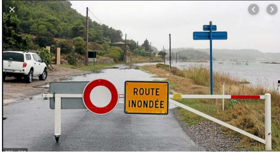
Fermeture Route, mise en place Déviations
