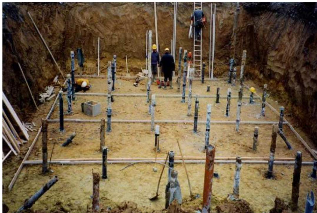
Fondations de piles de pont (pieux H à gauche et micropieux à droite)
