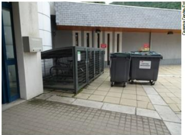
Gare de Moutiers – crédit photo : Cerema
