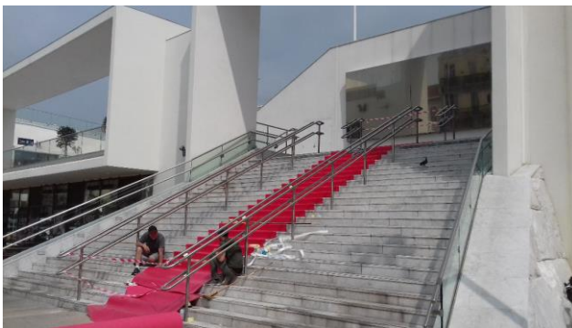
Escaliers à la gare de Cannes – crédit photo : Cerema
