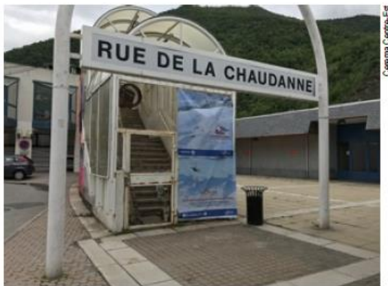
Accès condamné à une rue (gare de Moutiers) – crédit photo : Cerema
