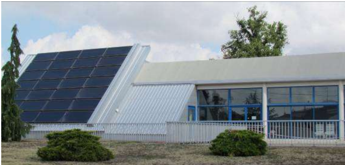
Piscine solaire - St Varent
