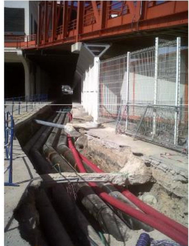
Tranchées sous Silo
