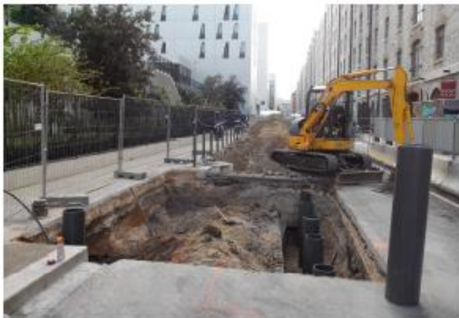
Puits de sortie - Docks
