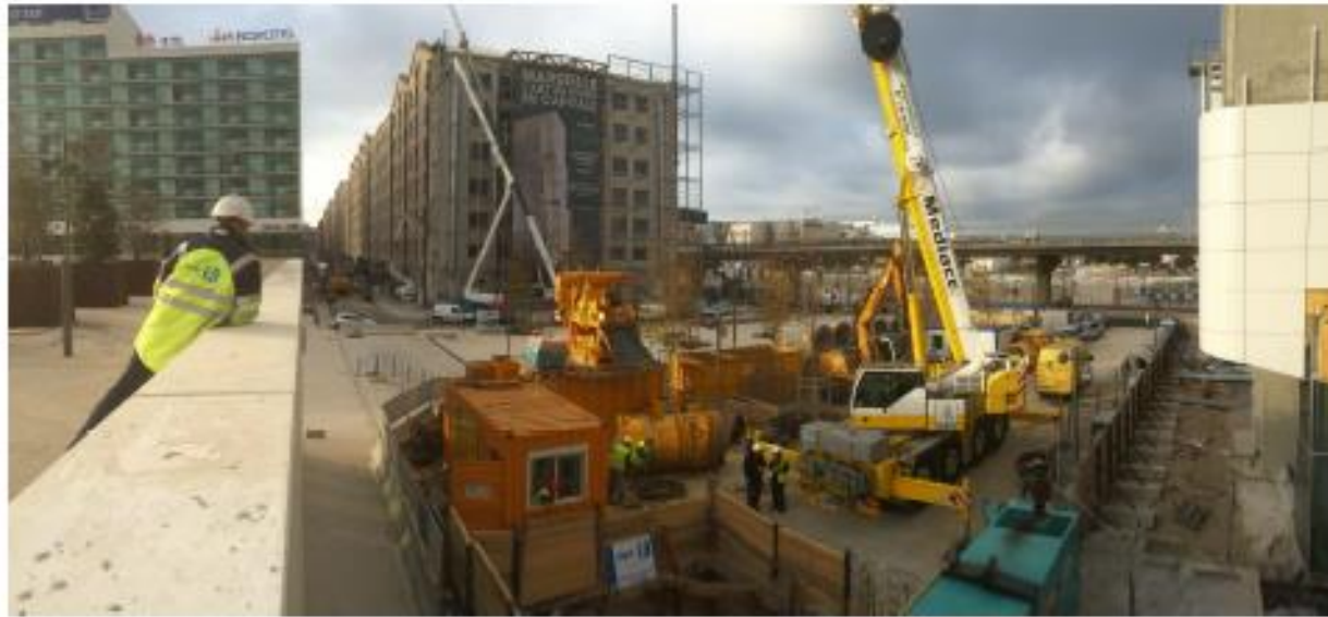
Arrivée du micro- tunnelier
