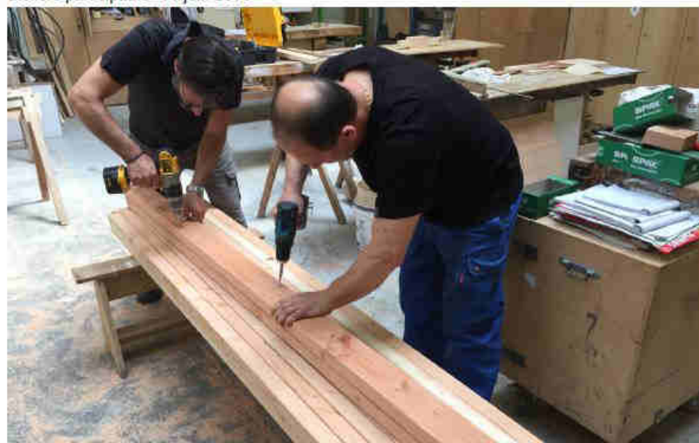
préfabrication des éléments de mobilier dans les Ateliers de la Ville de Montreuil - fin juin 2017
