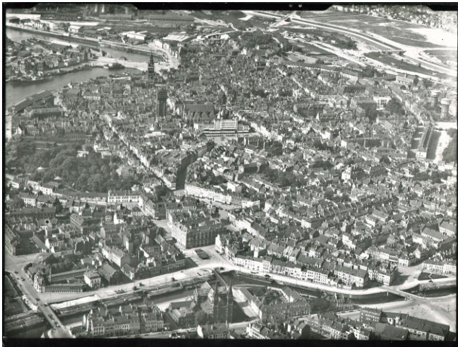
Vue aérienne Centre-ville de Dunkerque Avant seconde guerre mondiale Source: Institut National Géographique [IGN] _ Archives de Dunkerque _ CMUA
