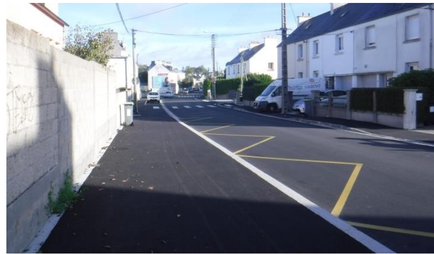
Après travaux : trottoir élargit avec arrêt de bus accessible tout public
