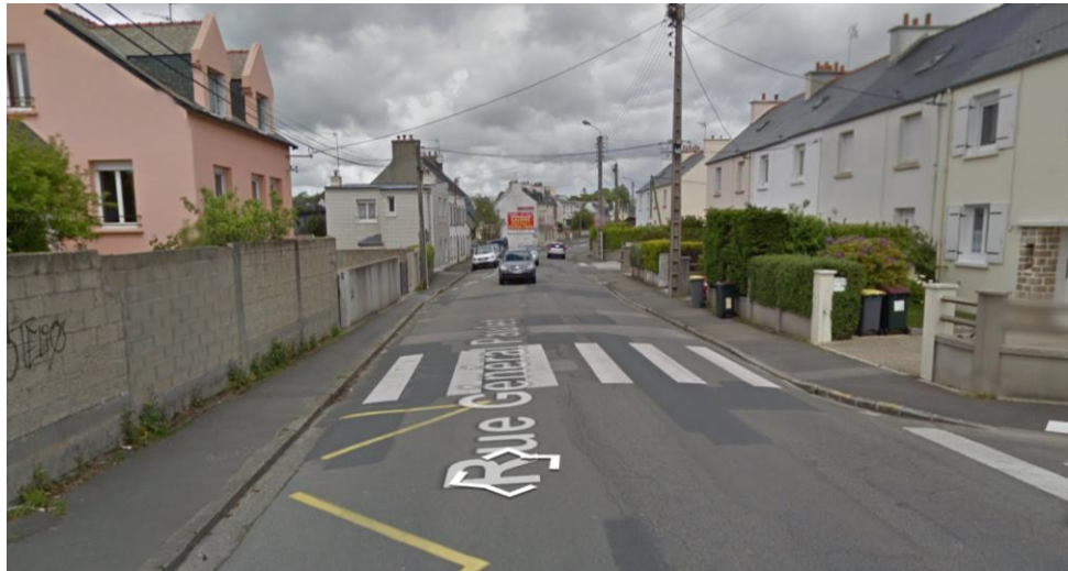
Avant travaux : trottoir côté gauche n'est pas aux normes
