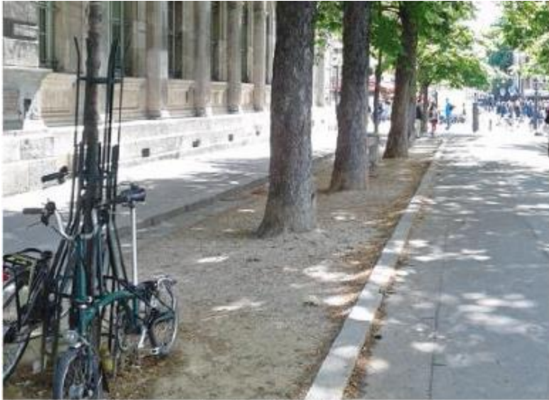
Tranchée continue avec bordure, Paris 4 e
