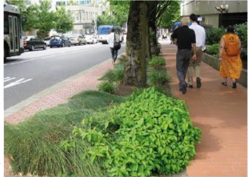
Tranchée continue recueillant les eaux pluviales, Portland
