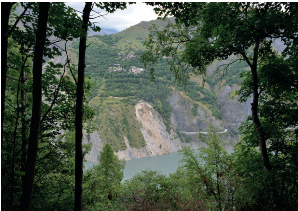
Illustration 8 : Le glissement du Chambon. Source Cerema
