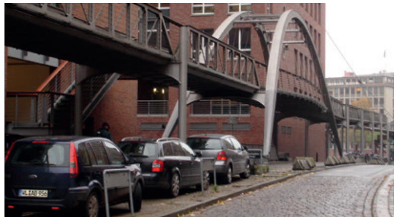
Illustration 4 : Le quartier Hafen-City (Hambourg) a aménagé des itinéraires de substitution à la voirie principale en période d'inondation.
