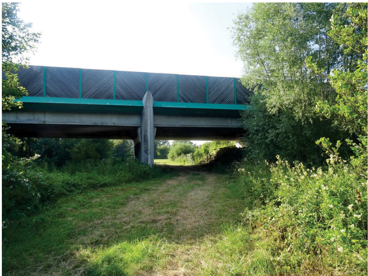
Illustration 11: Ouvrage d'art supportant l'A16 au-dessus de la Liane à Isques
