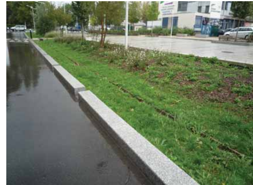
Noue – Réhabilitation les 4000 Nord
