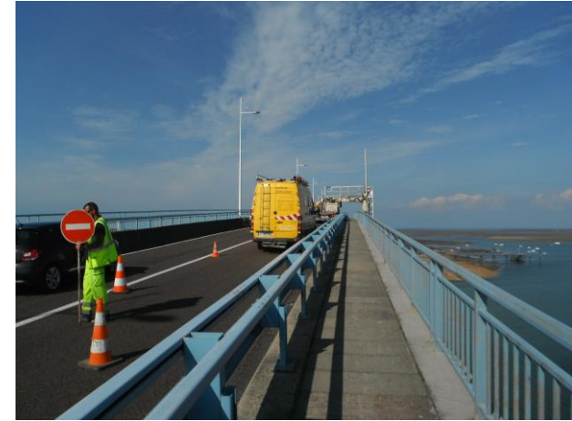
Circulation alternée manuelle pendant les interventions
