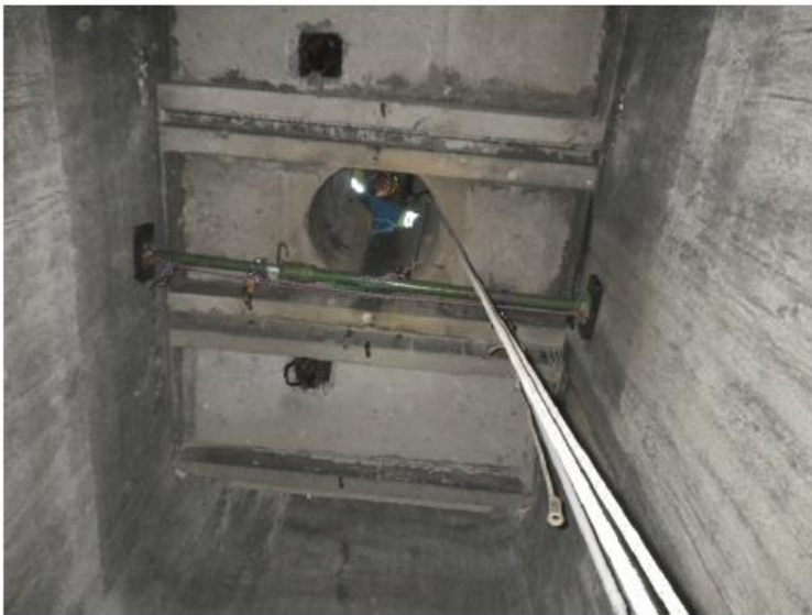
Installation du film à l'intérieur des piles
