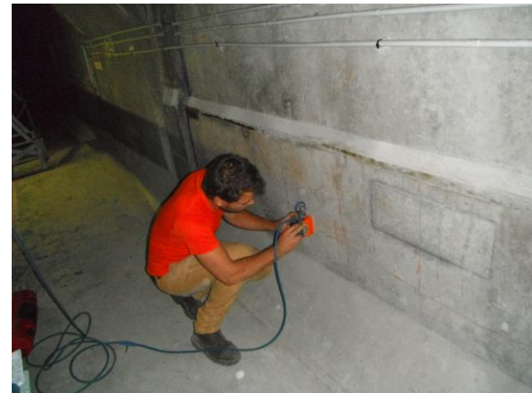
Localisation des armatures
