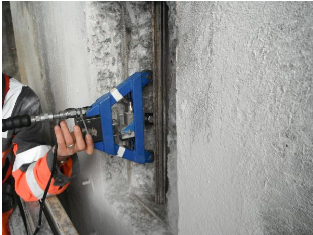
Essai à l'arbalète sur un toron de précontrainte verticale
