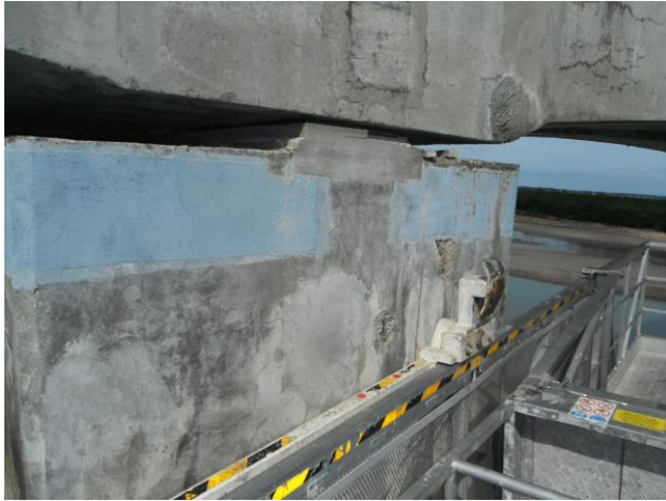
Accès avec la nacelle à 50 cm sous le chevêtre
