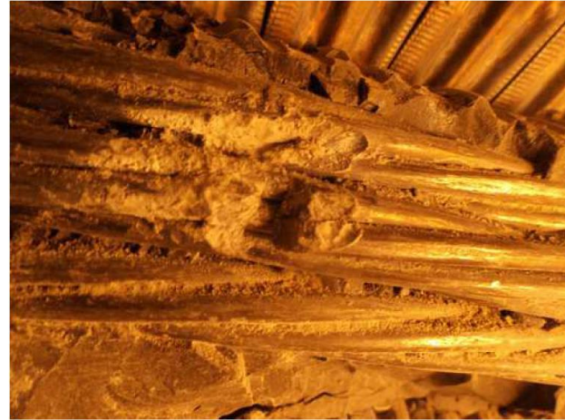
2 fils sectionnés en âme de voussoir
