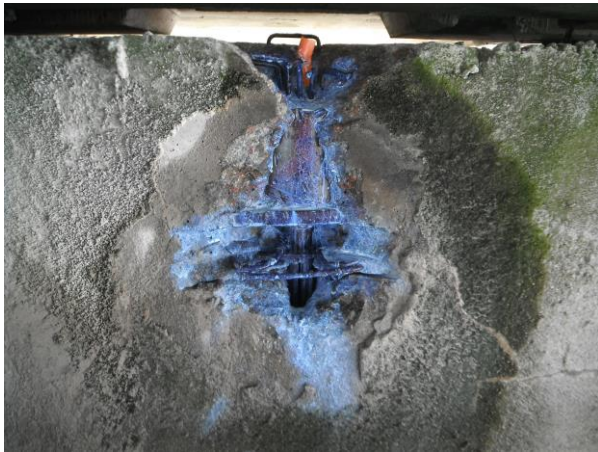
Passivant pour protéger contre la corrosion
