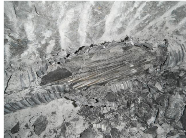
Ouverture d'une gaine de protection
