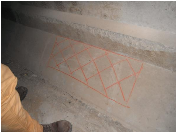
Tracé d'une fenêtre d'auscultation
