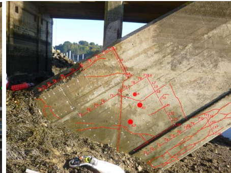
Zone Z2 : naissance arc amont - rive gauche
