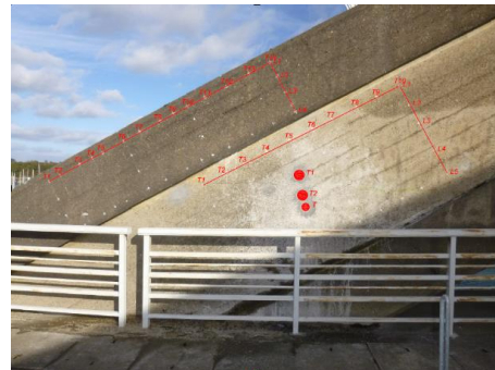
Zone Z3 : arc aval – niveau trottoir - rive gauche
