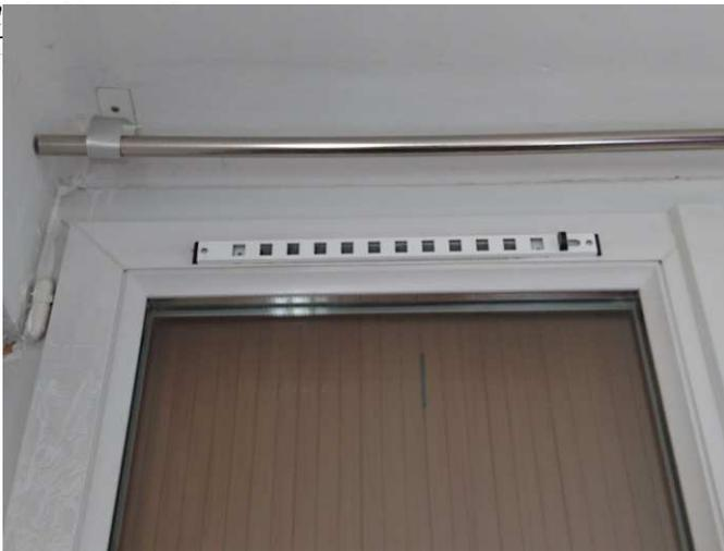
*Baguette d'entrée d'air obturables sur menuiseries*
