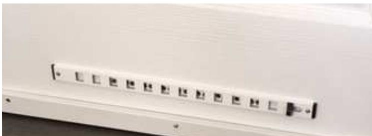
*Grille d'entrée d'air sur la porte, côté intérieur de la pièce*
