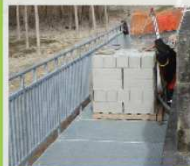
Mise en charge pour l'essai passerelle
