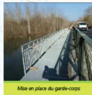
Mise en place du garde-corps
