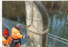
Repose de la stèle de limitation départementale
