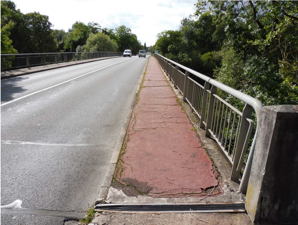
Trottoir amont du pont
