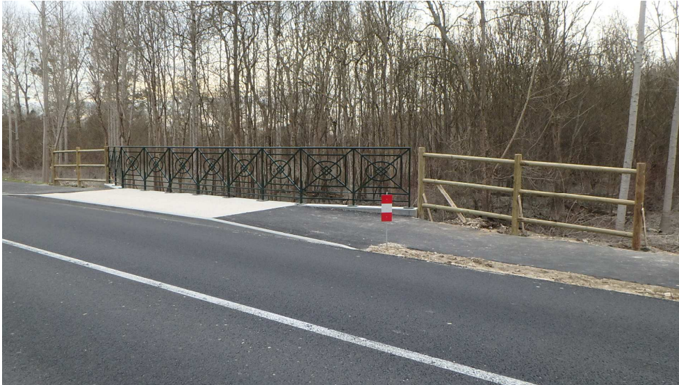
Mise en place de barrières bois
