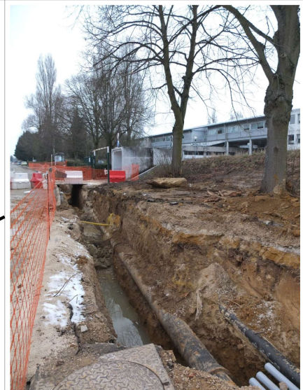
Figure 49: Venues d'eau observées dans diverses fouilles de la ZAC du Moulon
