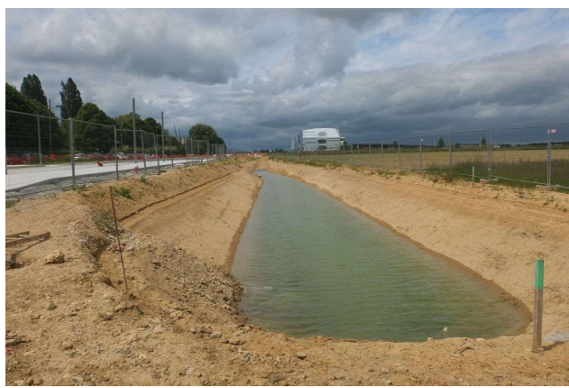
Figure 54: Bassin du DECK (mai 2015)
