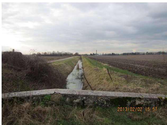
Figure 26: Vue de la rigole de Corbeville depuis le pont de pierre
