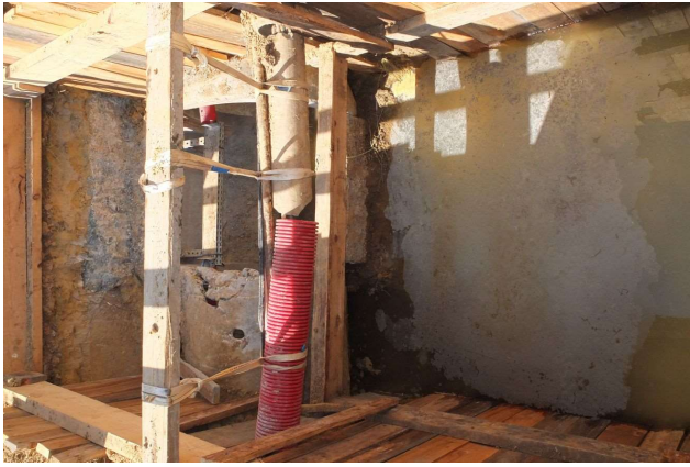
Figure 50: Venues d'eau dans une fouille située le long de la RN306 (24 juin 2014)
