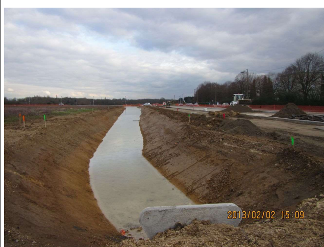
Figure 34: Réalisation du bassin du DECK (février 2015)
