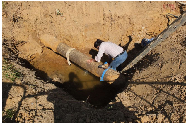
Figure 51: Mesure du niveau d'eau et prélèvement d'eau dans une fouille le long de la RN306 (24 juin 2014)
