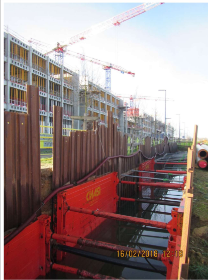
Figure 49: Venues d'eau observées dans diverses fouilles de la ZAC du Moulon
