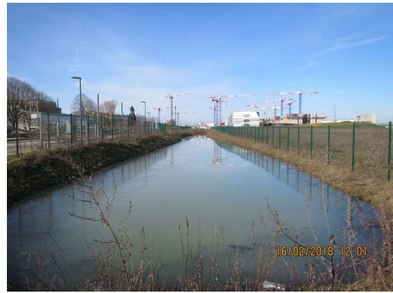
Figure 55: Bassin du DECK (février 2018)
