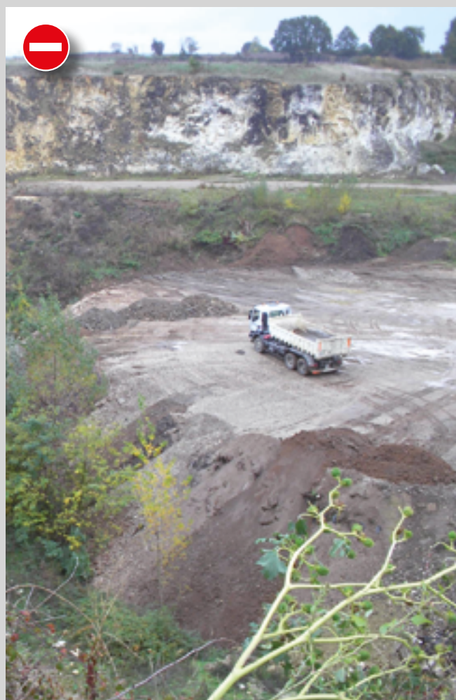
Pas de signalisation ni d'affichage de la zone de contrôle des déchets inertes (© photo : Cerema).
