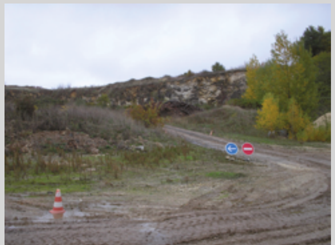
Panneaux de circulation dans l'ISDI (© photo : Cerema).
