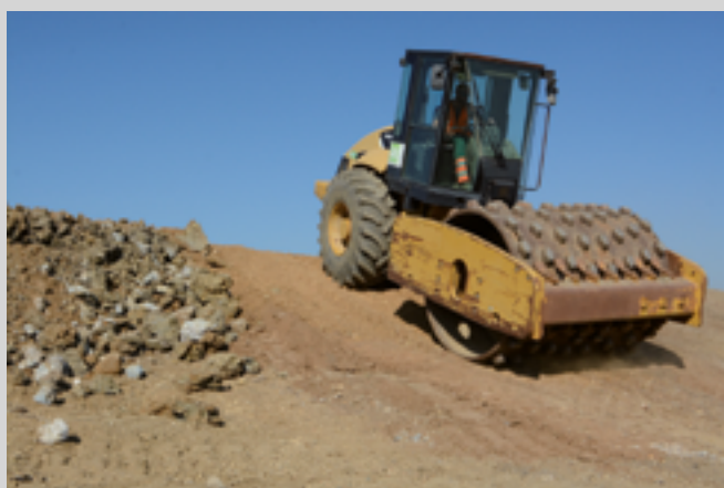
Exemple d'engin permettant de compacter les déchets inertes (© photo : UNED).
