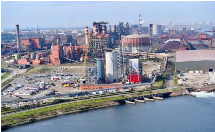
Récupération de chaleur fatale sur le réseau de Dunkerque
