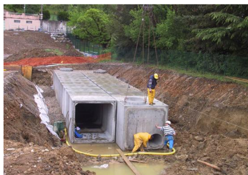
Photo 1: Conduite surdimensionnée - Photo Stracchi
