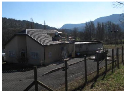
Photo 3 : Bassin tampon de la STEP des Salelles - Photo CC du Pays de Chanac
