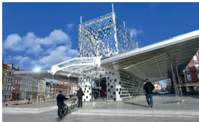
Abri vélo gare de Dunkerque. Source : Communauté urbaine de Dunkerque
