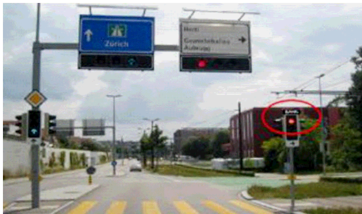
Figure 113 - Zurich, LED-signal „Bahn“
