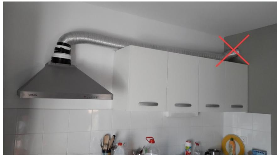
Hotte de cuisine motorisée raccordée au réseau de ventilation d'extraction
