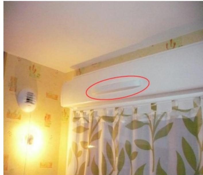
*Présence d'une entrée d'air dans une cuisine (pièce de service) – Disposition non conforme*
