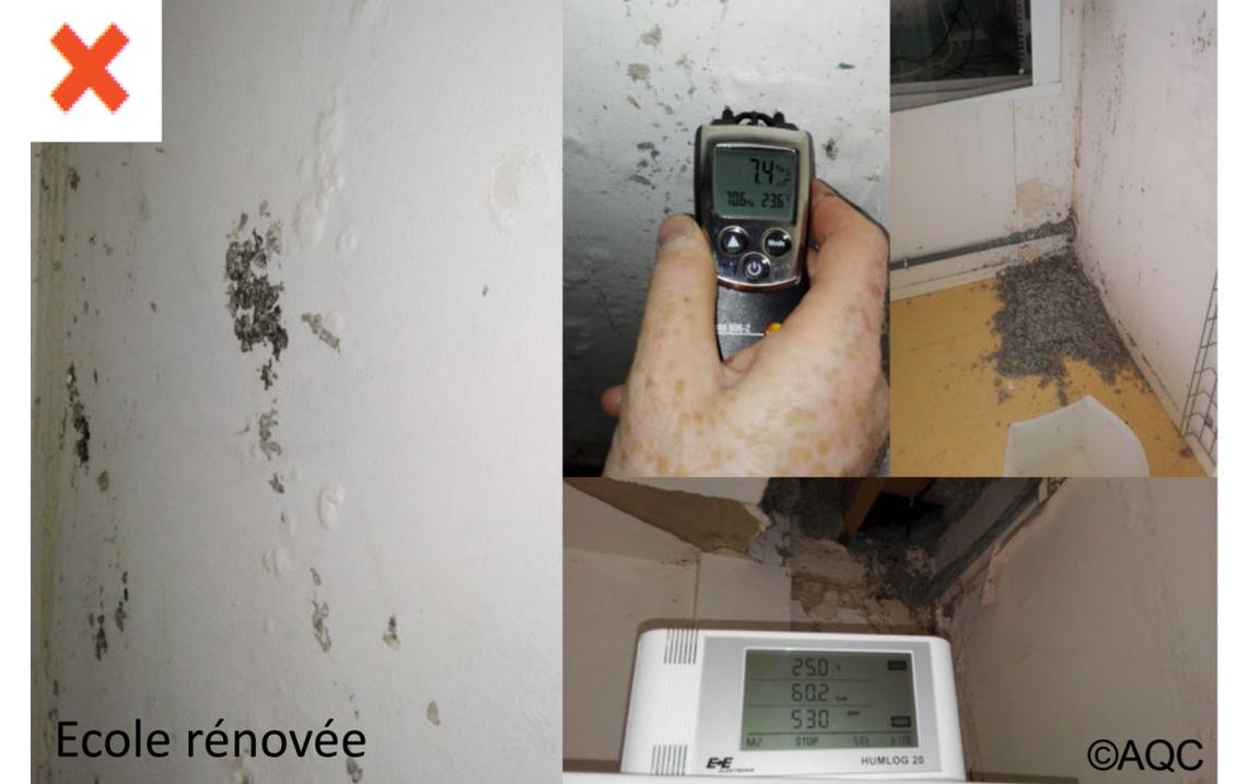
Revêtement intérieur dégradé avec présence de moisissures après la prise en charge d'un dégât des eaux dans un local technique non ventilé.
