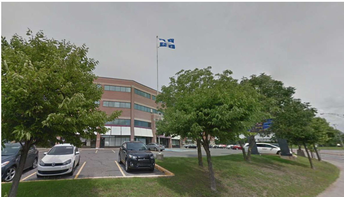
Illustration 1: Bureaux de l'Atrium – Locaux du Ministère - Québec
