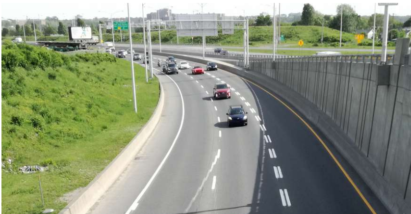
Illustration 14: Marquage double ligne discontinue
