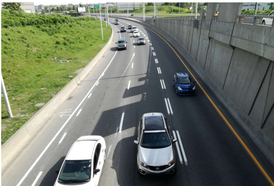
Illustration 28: Marquage double ligne discontinue A740
