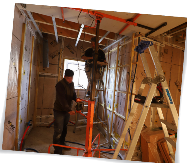
Projet de rénovation d'une longère - Lurais (36)
