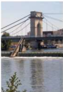
Pont du port à l'anglaise
