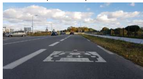
Voie réservée (section 300 m) direction Bordeaux
