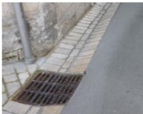
Caniveaux en pied de façades avec pavés éclatés 4 faces et sciés bouchardés sur face vue, de largeur 50 cm, le long de la bande de roulement en enrobé noir.
