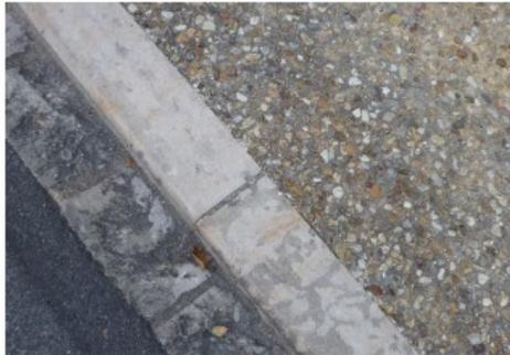
Sol Trottoir en béton de cailloux calcaire et silice teinté ocre, bordure en pierre sciée de Calminia et caniveaux pavés éclatés 6 faces de largeur 15 cm.
