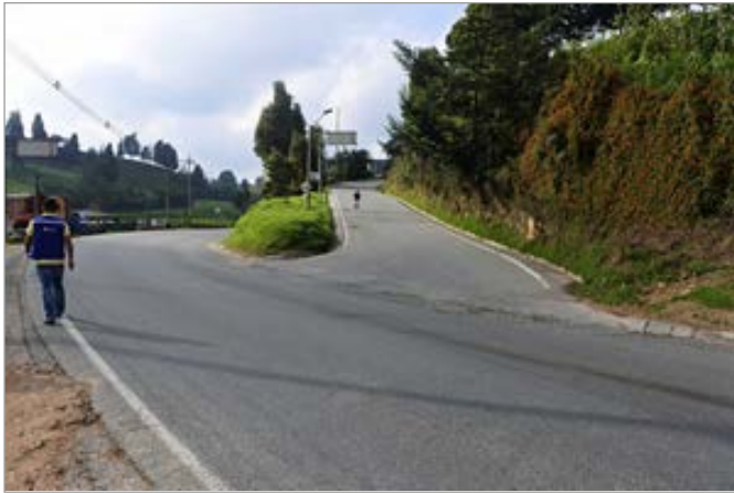
Falta de visibilidad y de legibilidad en una intersección
