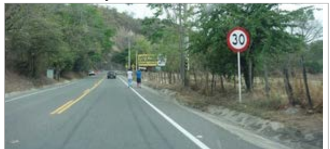
Ausencia de cambio del ancho de las vías antes de una zona escolar
