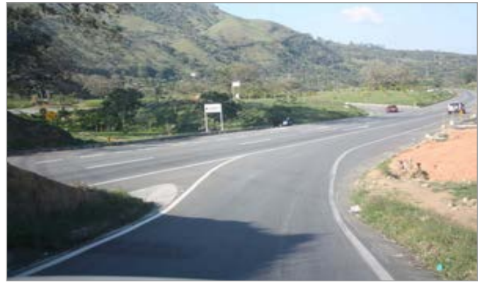
En vía de doble calzada entrada a una zona urbanizada antes de un retorno.
