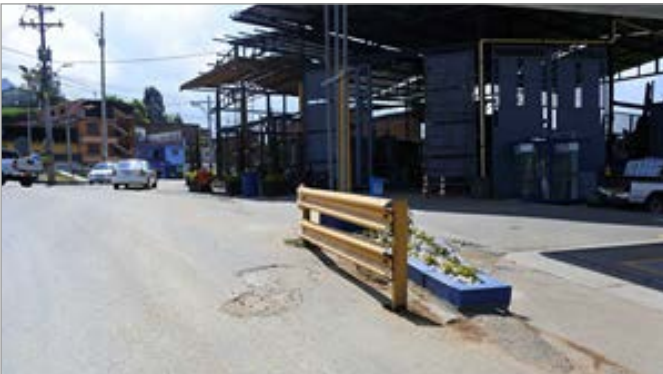
Francia: Baranda metálica simple. Dispositivo de contención flexible
