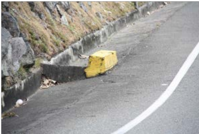
Ejemplo de colocación de los cabezotes por detrás de las alcantarillas.
