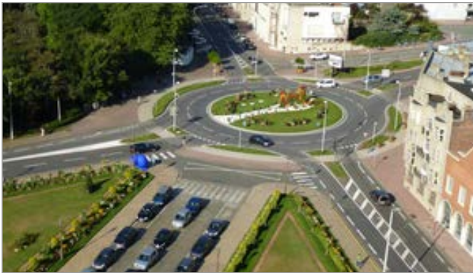
Se desvía la trayectoria del vehículo obligándolo a disminuir la velocidad. Ruptura de la perspectiva para percibir mejor la pérdida de la prelación. Es aconsejable, sin embargo, mantener un solo vía en el anillo.
