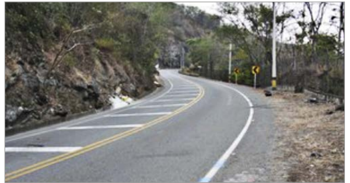
Alerta en forma de líneas blancas antes de una curva.
