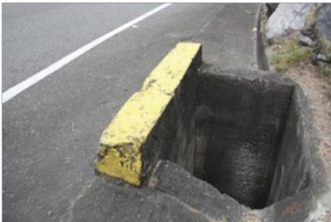
Ejemplos de cabezotes que generan obstáculo en la berma
