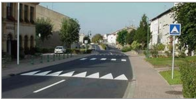
El resalto obliga a los carros a disminuir la velocidad a nivel del paso.
