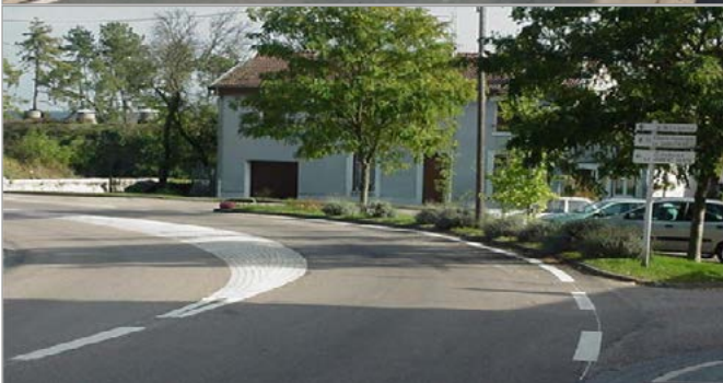
Resaltos sobre los cuales se puede transitar a baja velocidad para evitar que los vehículos corten el viraje.
