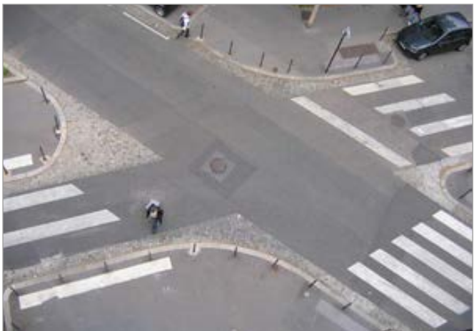
Sobreebancho para permitir que los vehículos pesados giren y a la vez reducir la velocidad de los vehículos debido a la ortogonalidad de la trayectoria.
