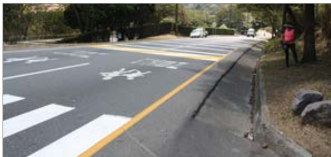
Zona escolar en el norte de Medellín. No se observa ninguna disminución de velocidad.
