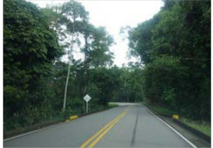
Ejemplo de colocación de los cabezotes por detrás de las alcantarillas.
