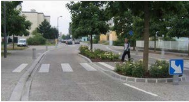
La chicana desvía los vehículos para obligarlos a disminuir la velocidad y provoca una ruptura de la perspectiva visual (Guía de chicanas y esclusas de Cerema).
