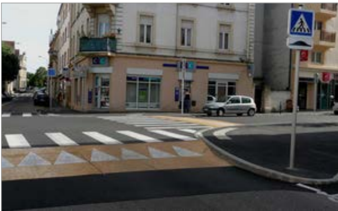
El resalto obliga a los vehículos a disminuir la velocidad para entrar a la intersección.
