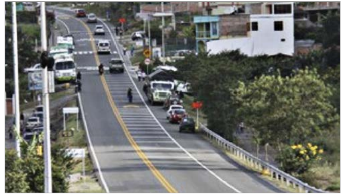
Alerta en forma de líneas blancas antes de una escuela.
