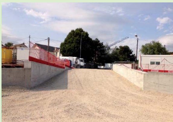
Rampe d'accès du chantier (pente de 10 %)
