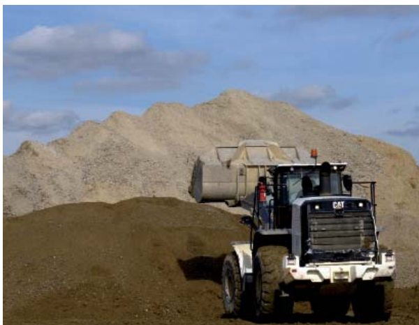
Photo 5 : Stockage des matériaux (crédit photo : YPREMA)
