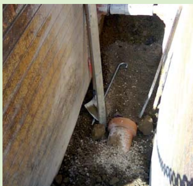
Tranchée d'une conduite d'eau potable
