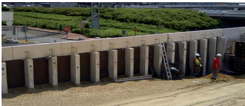
Photo 6 - Exemple d'usage des matériaux chaulés en remblaiement derrière un ouvrage d'art
