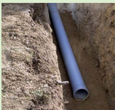
Enrobage d'une canalisation en grès et remblaiement de la tranchée
