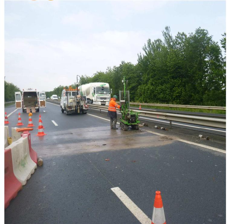
Mise en œuvre d'un solin en enrobé. Protection du fontis par chutes de panneaux métalliques
