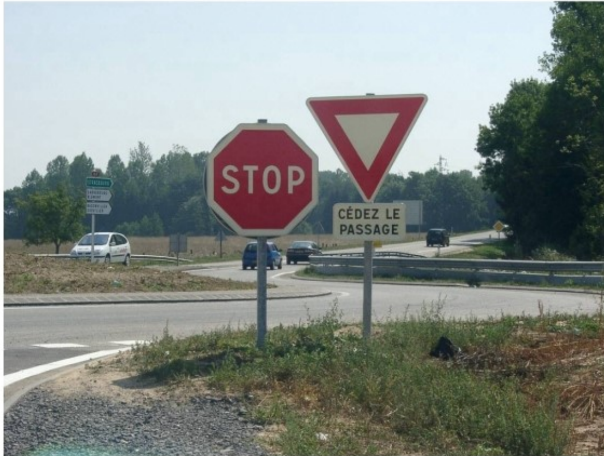
Diffuseur de Bénoménil - Giratoire Sud Signalisation inappropriée bretelle de sortie vers giratoire sud
