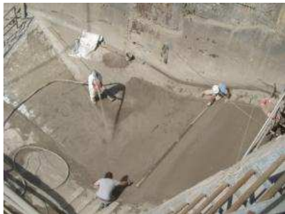
Déversoirs de barrages
