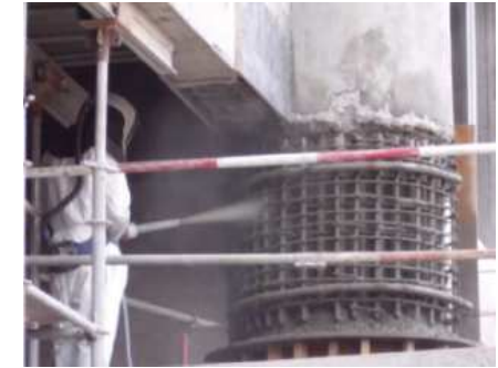
Réparation après incendie
