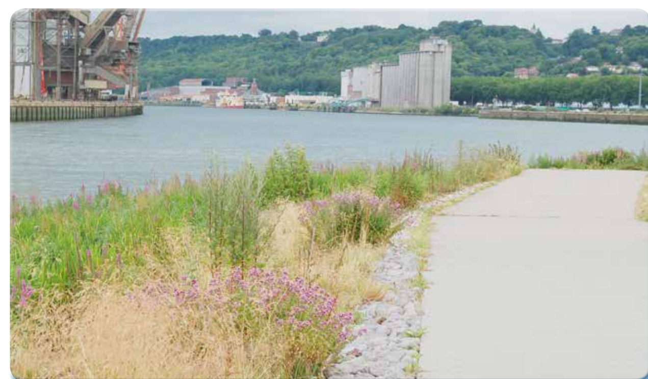
Berge renforcée par un matelas de gabion
