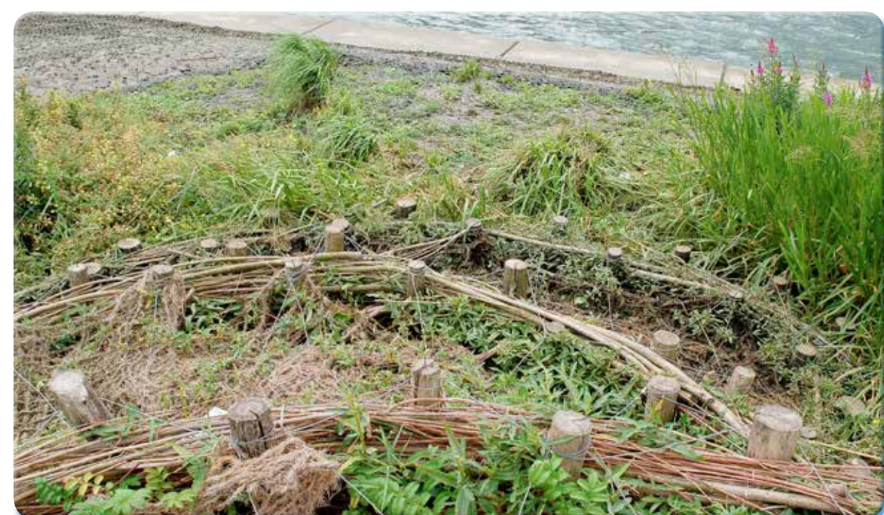
Berge renforcée par des fascines plantées
