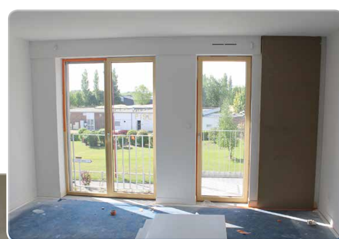
Le mur en terre est de la même épaisseur que le reste du mur en ossature bois : 48 cm de limon argileux, chaux et fibres de lin
