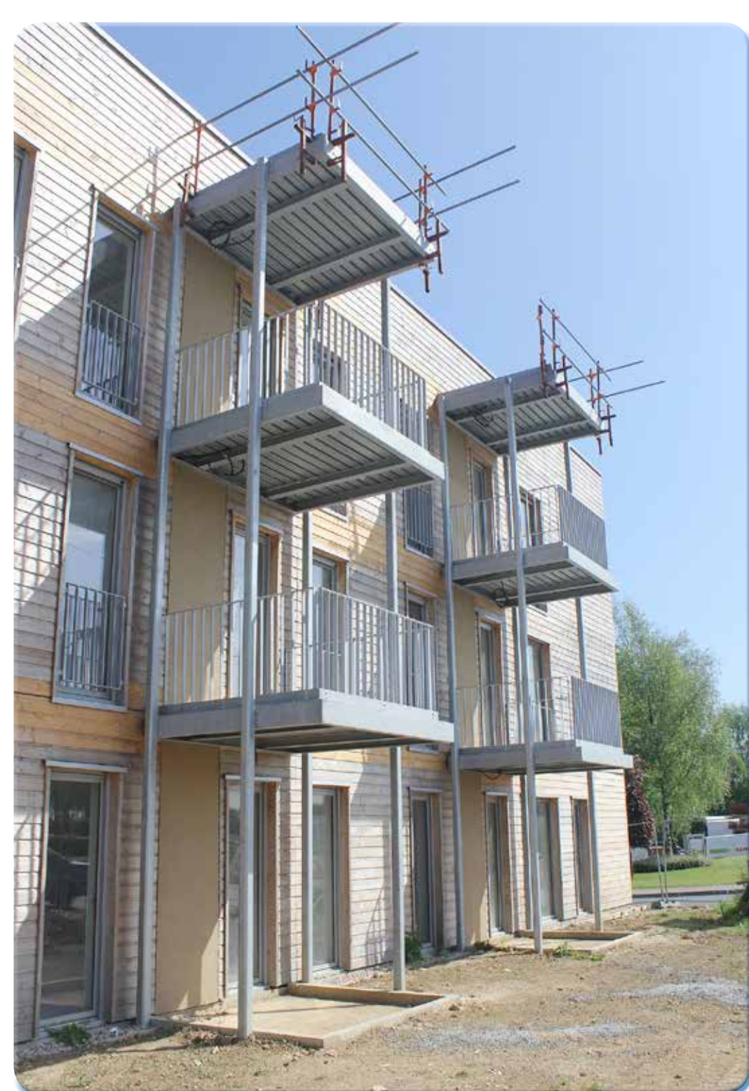
Chaque logement possède son mur en terre et son balcon vitré
