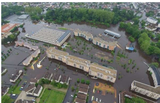
Photo aérienne du quartier Matra durant la crue de juin 2016 (source : ville de Romorantin)
