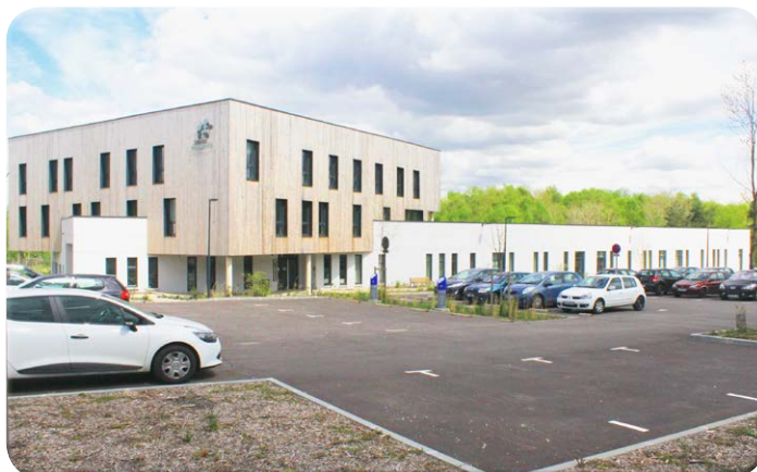
Bâtiment Seine-Ecopolis © Cerema
