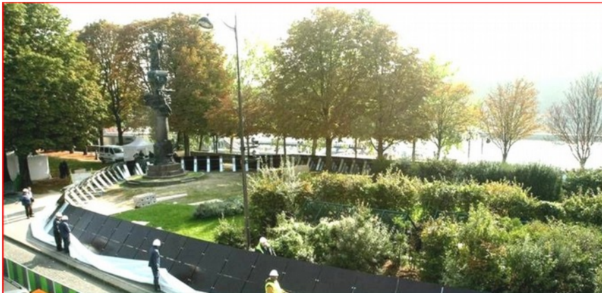
Aquabarrière autour d'un poste électrique près du pont de l'Alma
