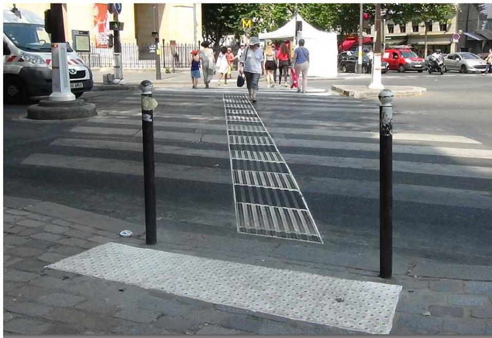
Dessin 1: Implantation des dispositifs au centre du passage piéton, dans l'axe de la BEV
