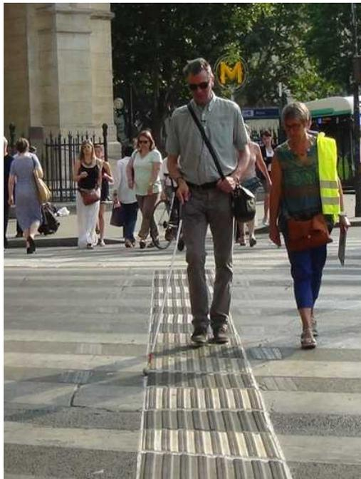
Dessin 3: le dispositif 3 apprécié : différent de la BEV et permet un bon repérage, mais jugé inconfortable par la majorité des testeurs
