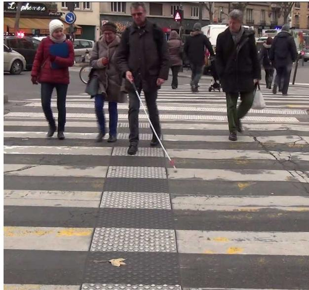
*Illustration 17: Dispositif détectable facilement et confortable pour les pieds*
