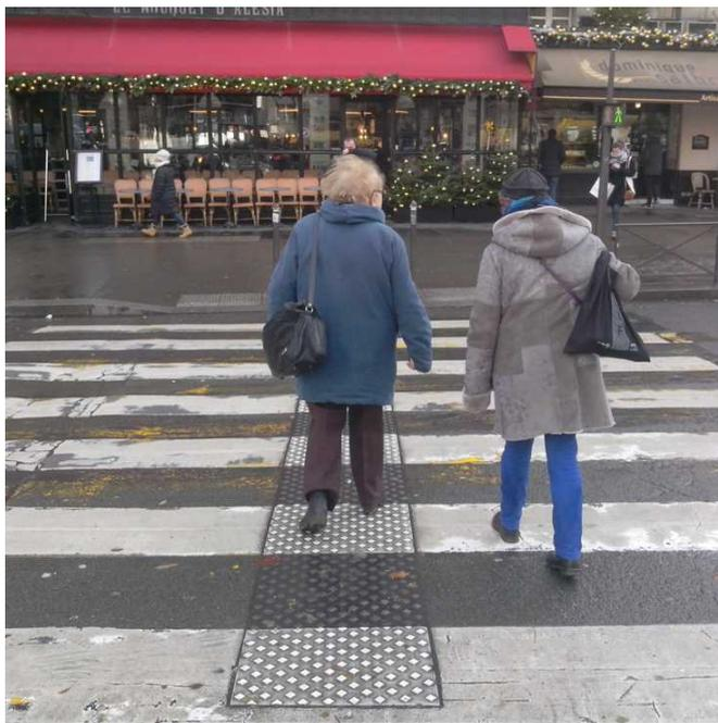
Illustration 19: Les testeurs détectent les dispositifs visuellement puis les suivent aux pieds, sauf le 3 pour lequel ils marcheraient à côté.
