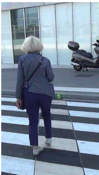
Illustration 17: Produit 1, les pieds peuvent se bloquer dans les rainures
