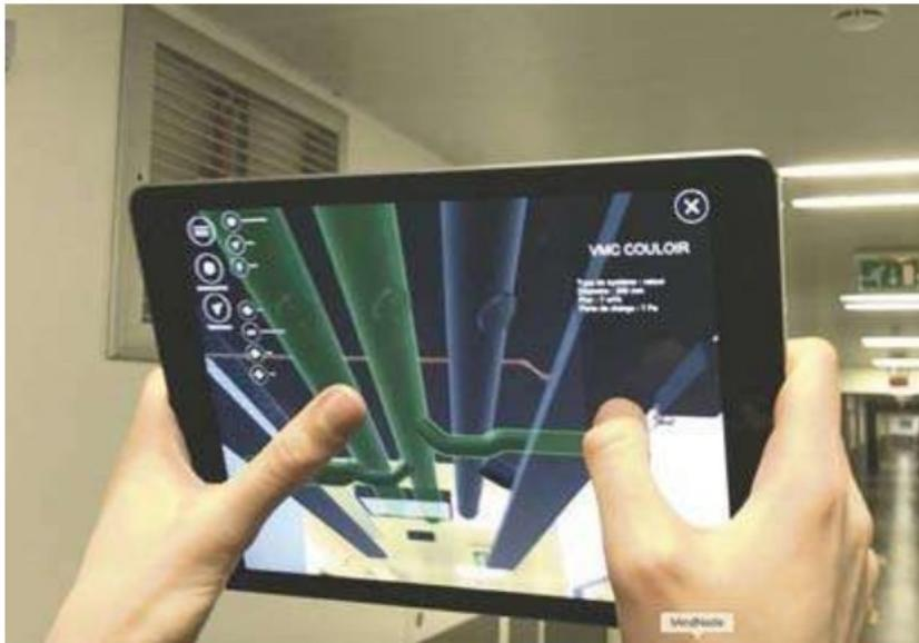
La réalité augmentée sur tablette montre les circuits de fluides qui sont cachés sous le plafond au CHU de Caen.
