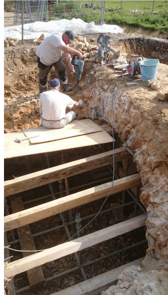
Démolition de la partie aval de l'arche 3 très endommagée par la végétation
