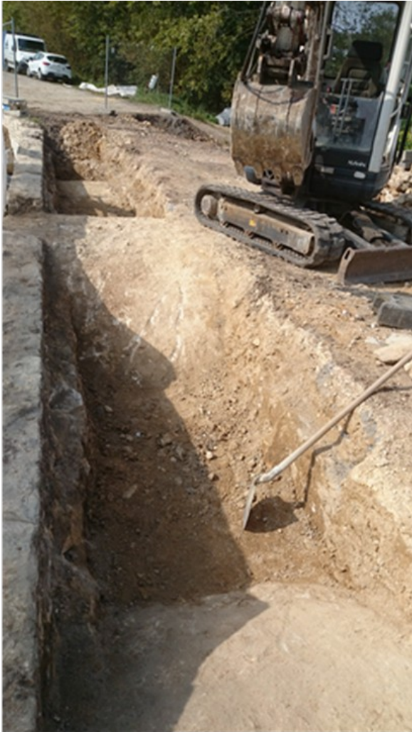
Dégagement du dessus des voûtes
