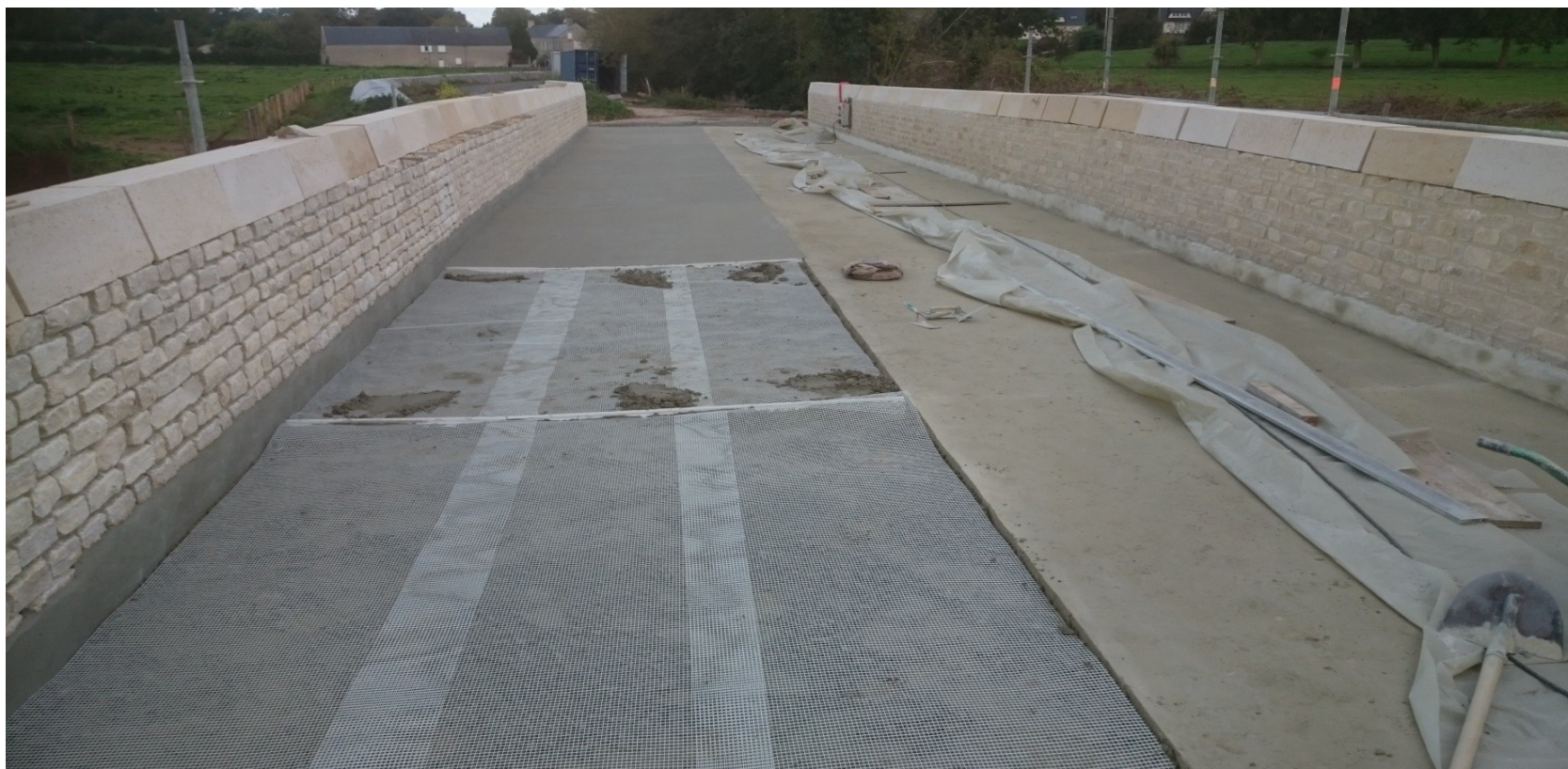
Réalisation de la chape ciment/chaux
