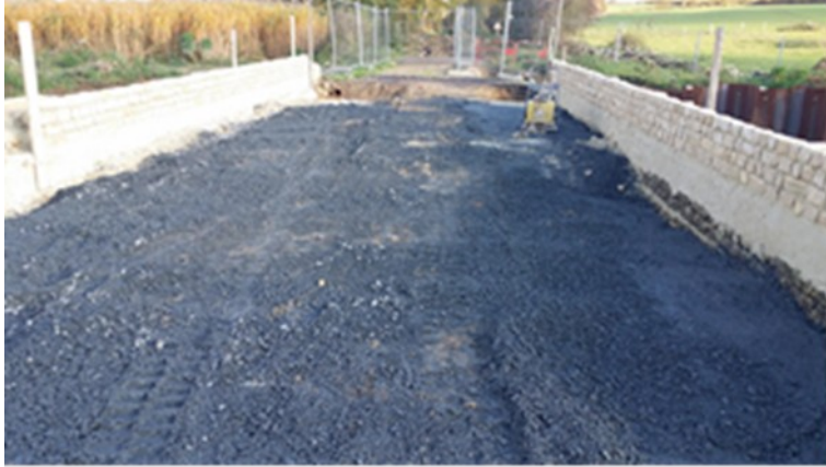
Mise en place du remblai contigu
