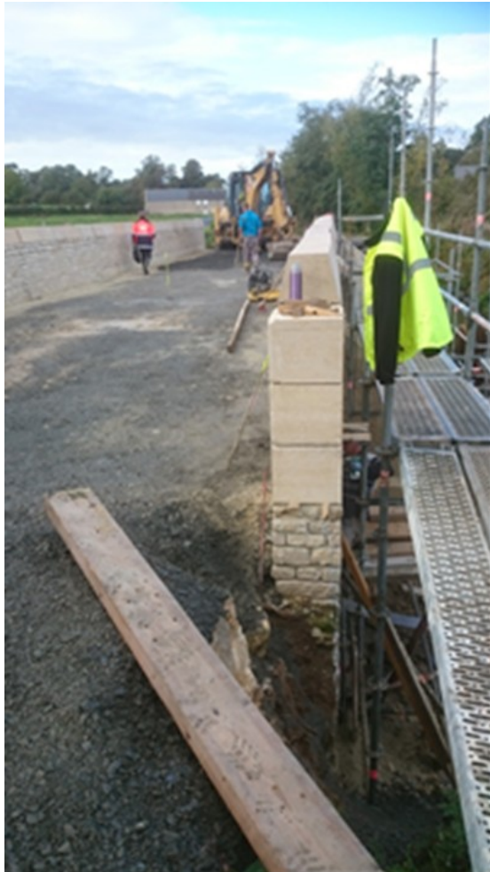
Finition parapets et réalisation de la chaussée
