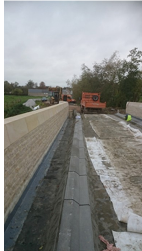
Finition parapets et réalisation de la chaussée
