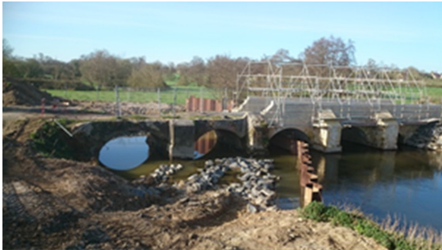
Pose du batardeau phase 2
