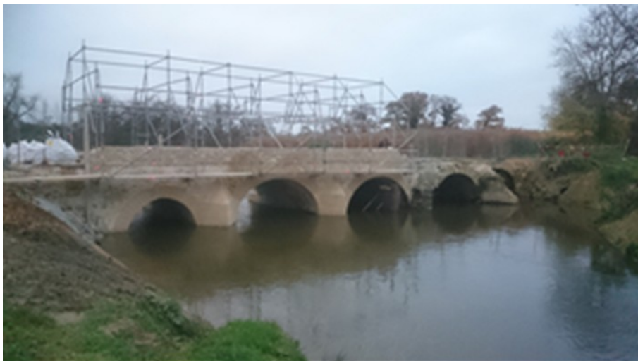
Dépose des batardeaux
