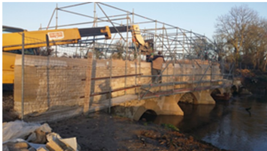
Réalisation des parapets de la phase 1
