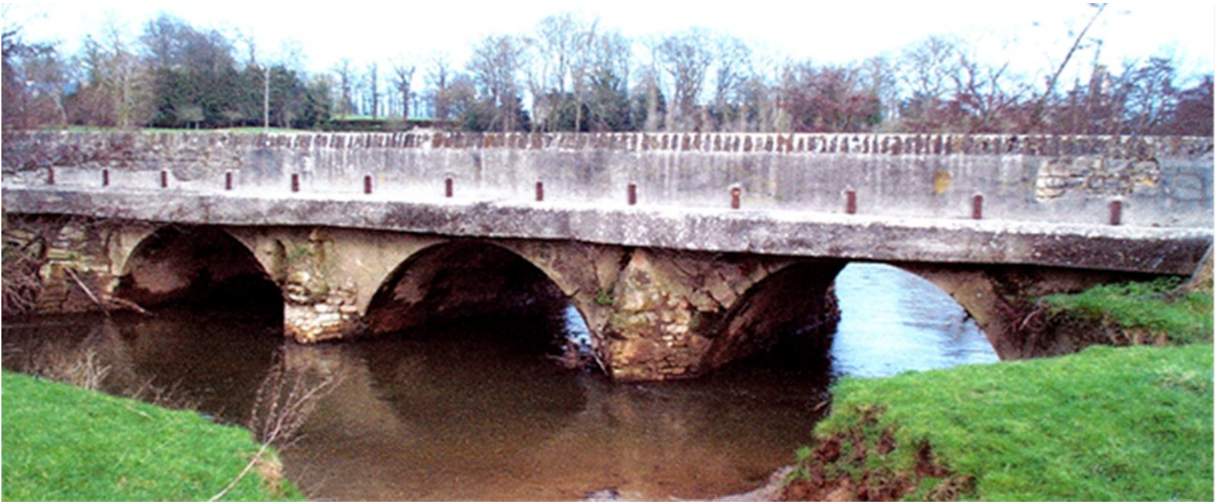
Vue amont du pont de Barbeville
