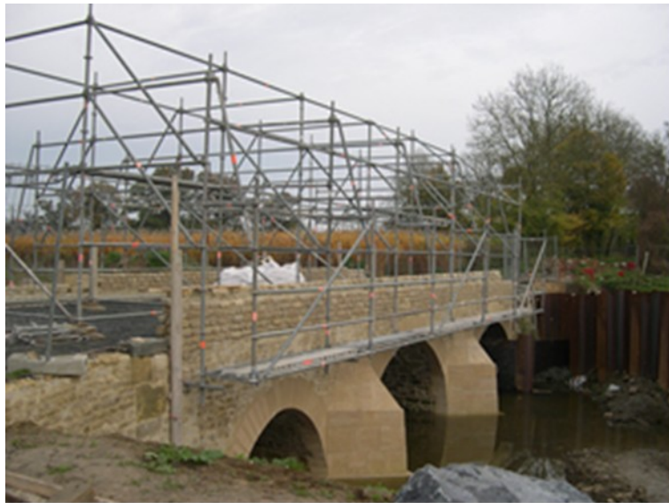
mise en place des échafaudages en encorbellement
