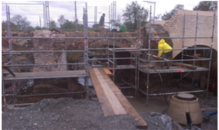
Dépose et repose des échafaudages et piquetage des joints
