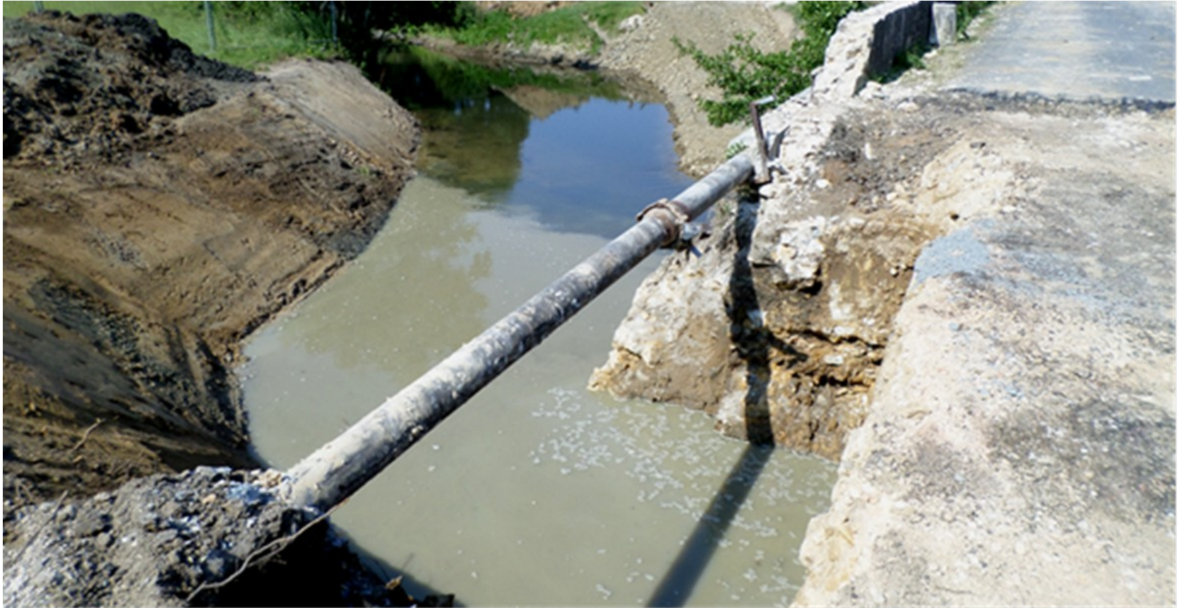
Dégagement de l'arche n°5
