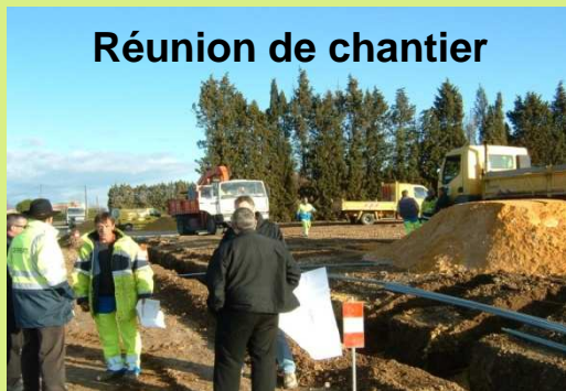
Mise en place réseau électrique et téléphone
