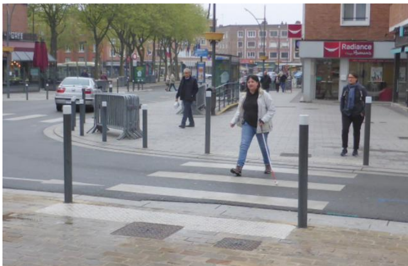
Illustration 16: Au niveau de T3, détection tactile et visuelle de la BEV
