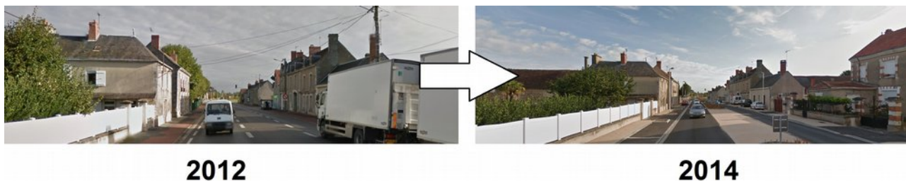
figure 60 : Réaménagement de la traversée du centre bourg d'Ingrandes
