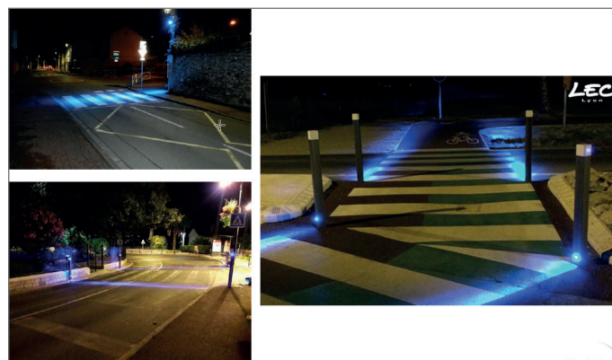
Contrastes chromatiques permettant de matérialiser des traversées piétonnes après la tombée de la nuit
