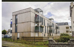
Opération « Ondine » à Saint-Brieuc (Saint-Brieuc Agglomération)
